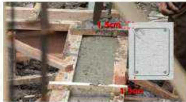
Gambar II.378 Balok Pengikat/ Sloof
