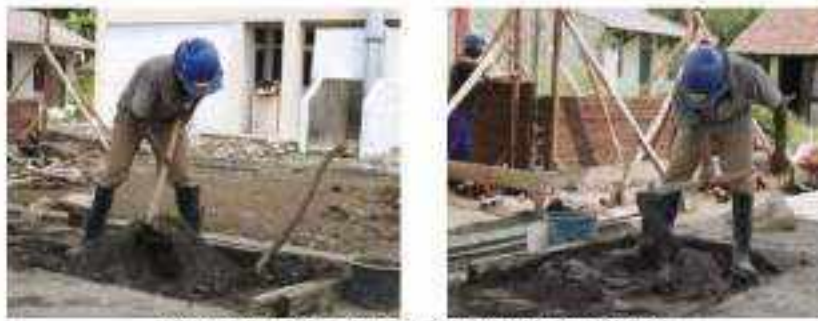
Gambar II.367 Proses Pencampuran Mortar
