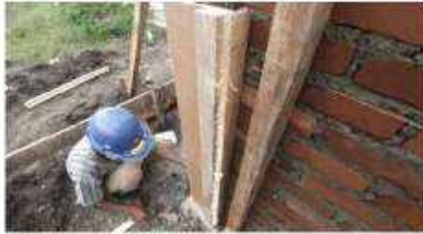
Gambar II.414 Pemasangan Cetakan/ Bekisting Untuk Kolom
