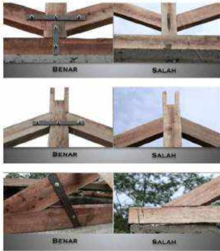
Gambar II.388 Pemasangan Plat Baja Pada Kuda-kuda Kayu.
