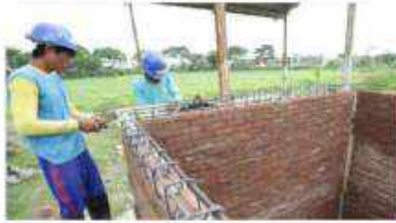
Tulangan balok keliling/ring dirangka di atas dinding
