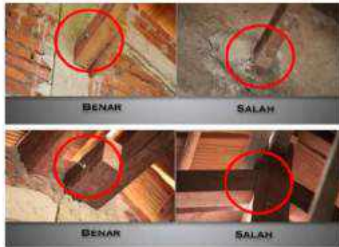
Gambar II.397 Contoh Detail Pertemuan Antara Ikatan Angin dengan Gunung-Gunung/ Anggig
