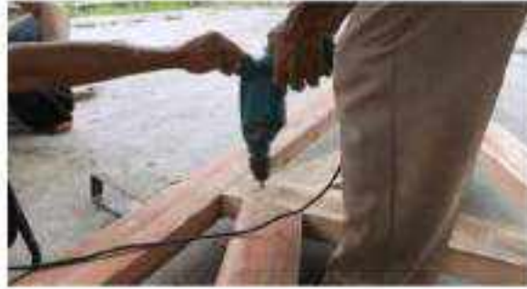
Gambar II.390 Pemasangan Plat Baja Pada Kuda Kuda Kayu Menggunakan Bor Listrik
