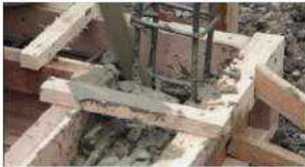
Gambar II.418 Pengecoran Balok Pengikat/ Sloof
