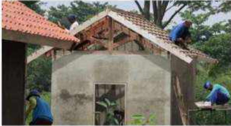
Gambar II.386 Kuda-kuda Kayu Pada Atap Rumah Tinggi
