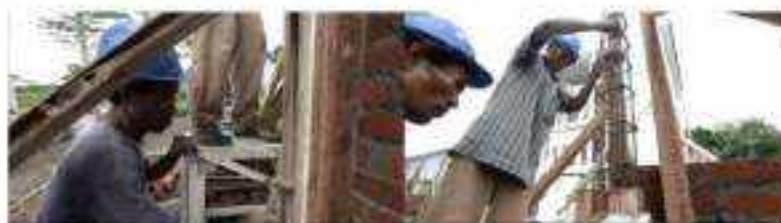
Gambar II.416 Pemaslatan Beton Dengan Memukul-mukul Cetakan/ Bekisting dan Campuran Beton Dirojok Menggunakan Besi atau Bambu
