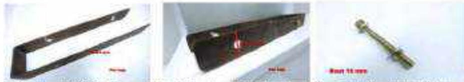
Gambar II.389 Dimensi Plat Baja dan Baut Sebagai Pengikat Kuda-Kuda Kayu.
