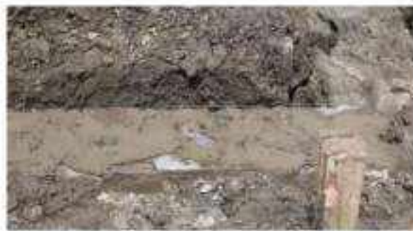
Gambar II.370 Pondasi Dari Batu Kali/Gunung
