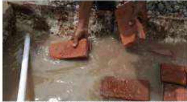
Gambar II.374 Perendaman Batu Bata Sebelum Dipasang
