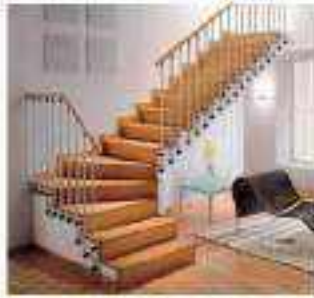
Gambar II.128. Contoh penerapan tangga kipas
