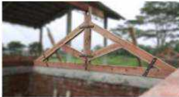
Gambar II.387 Kuda-kuda Kayu Dengan Pengikat Plat Baja
