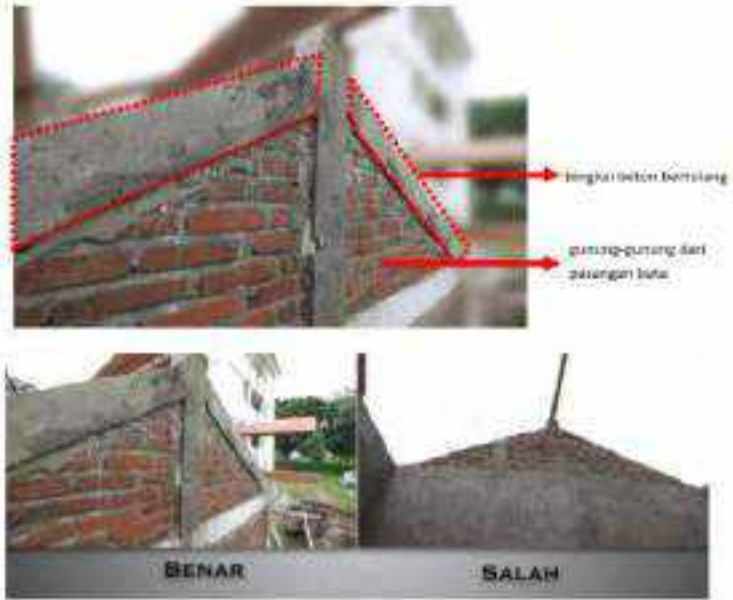
Gambar II.391 Gunung-Gunung / Ampig
