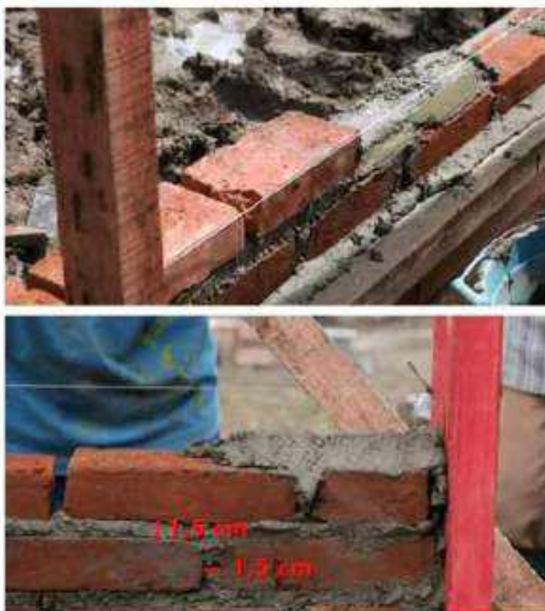
Gambar II.400 Proses Pemasangan Batu Bata Untuk Dinding
